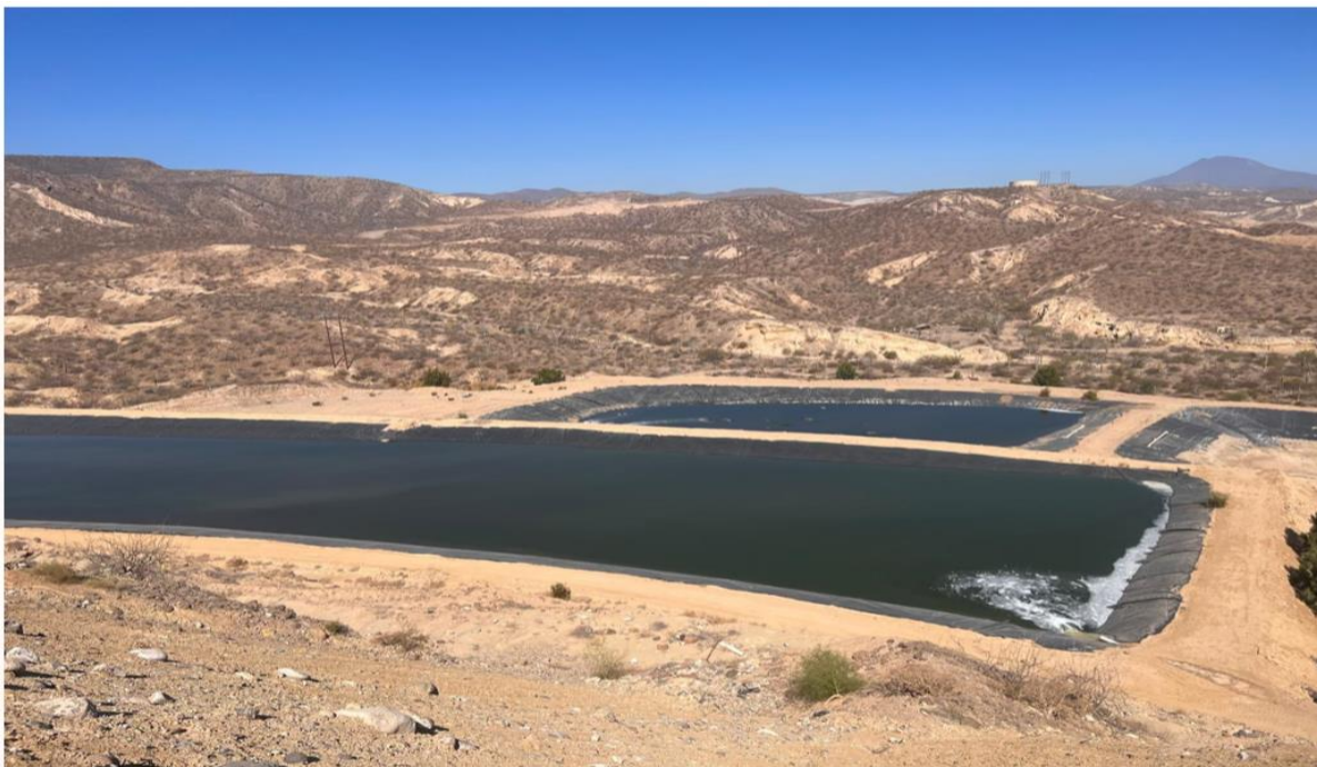
Lagunas de oxidación en Santa Rosalía, Baja California Sur.
